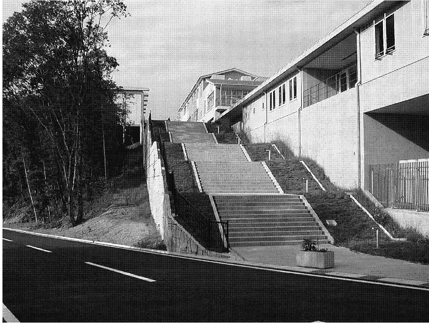
写真5. 南山城小学校へアプローチする階段（右手前は保健福祉センター、右奥は保育園）
