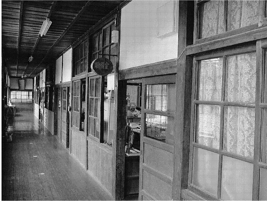
写真8. 田山小学校廊下
